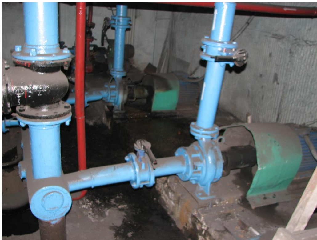
Рисунок 1.4 – Сетевые насосы котельной с. Новомихайловка
