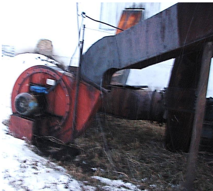
Рисунок 1.7 – Дымосос котельной с. Новомихайловка
