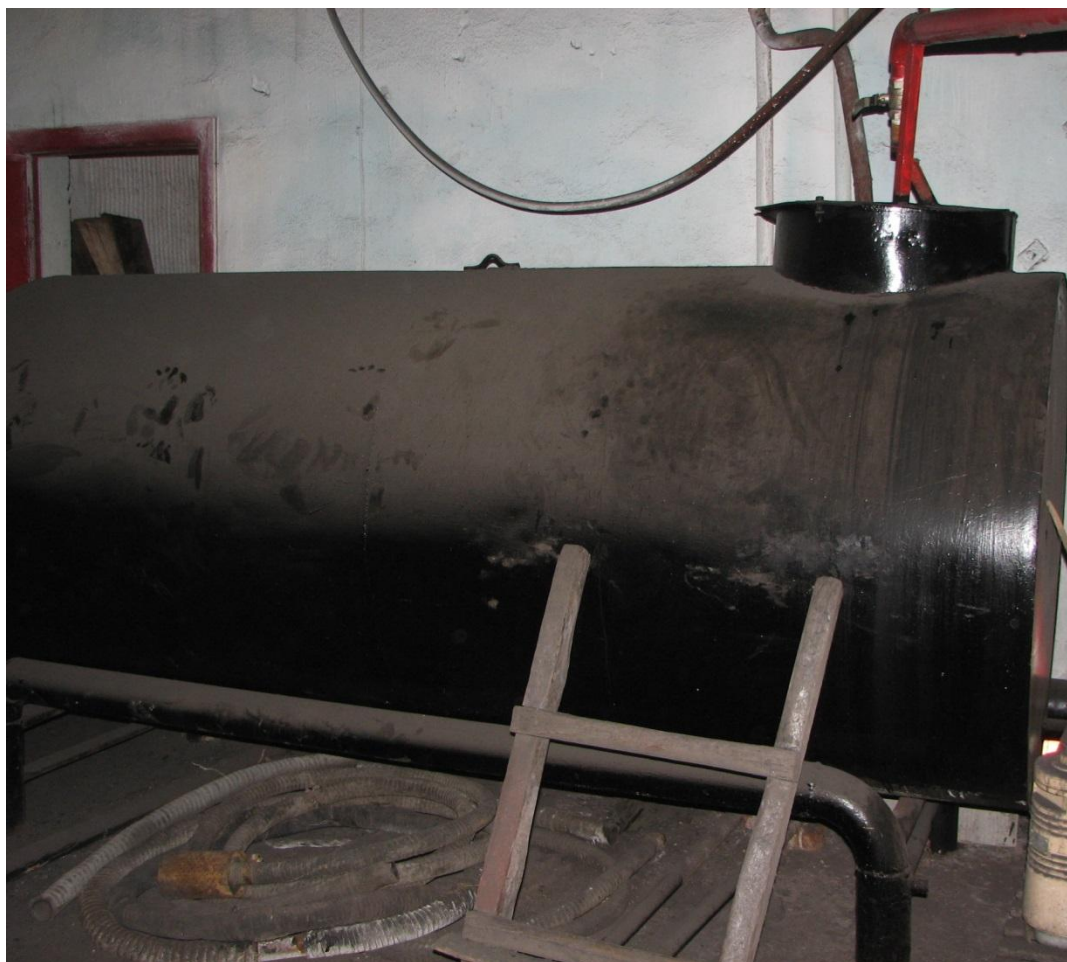
Рисунок 1.9 – Бак запаса подпиточной воды, установленный на котельной в д. Новомихайловка
