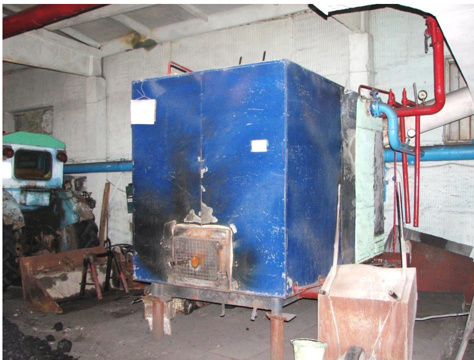
Рисунок 1.3 – Котел «КВр-1,25», установленный на котельной с. Новомихайловка
