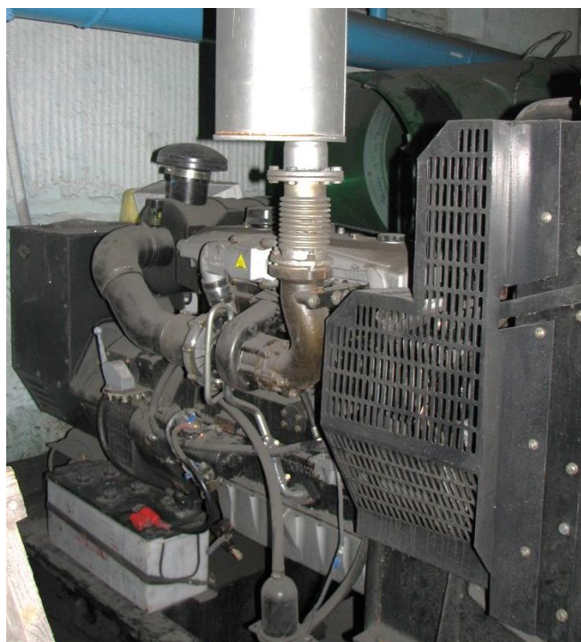
Рисунок 1.8 – Дизель-генератор, установленный на котельной в д. Новомихайловка
